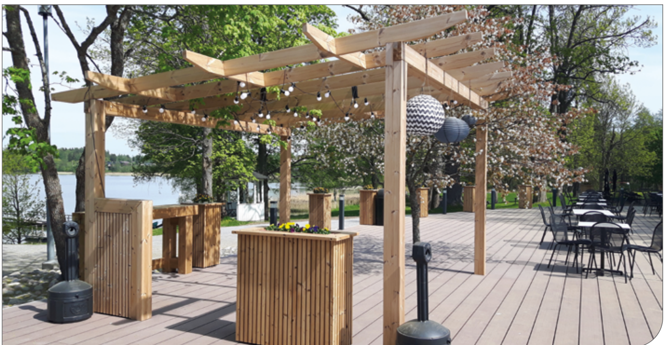
Abbildung 33. Verleimte ThermoWood®-Balken in Pergola
