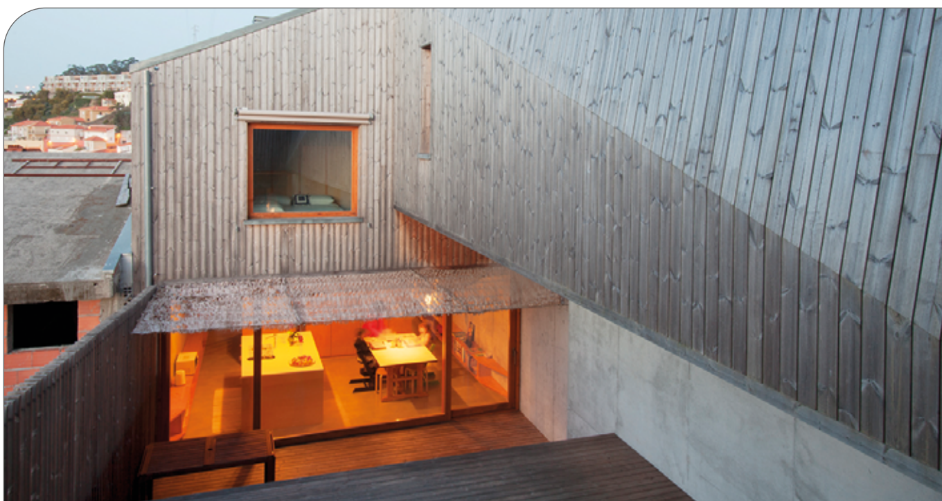
Abbildung 61. Außenwandverkleidung mit natürlicher Verwitterung (Portugal)
